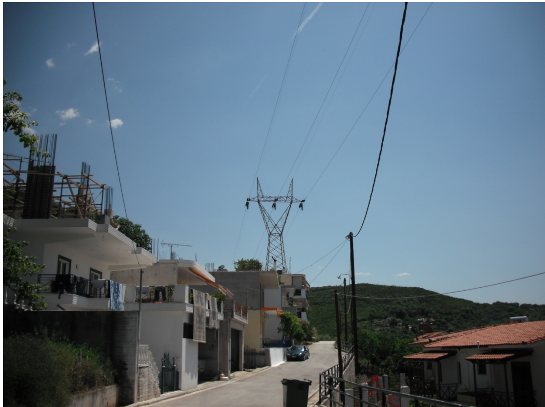
Φ26 & Φ27 – Διέλευση Γραμμών Υψηλής Τάσης ΔΕΗ από τον οικισμό του Μενιδίου
